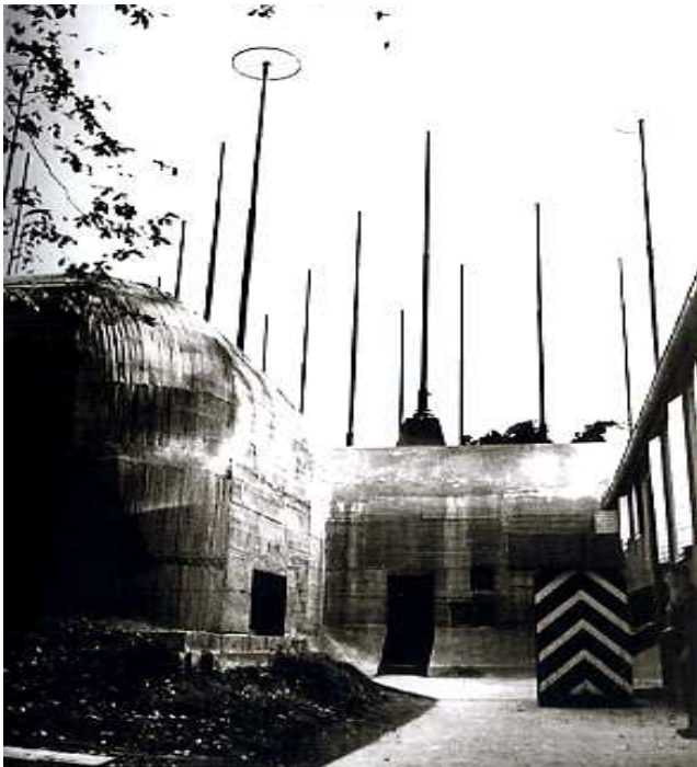
Accès du Bunker-Amiral vers 1943. Le bunker est surmonté d'antennes avec à leur extrémité un élément en forme de roue de bicyclette. Photo coll. MECKEL.
